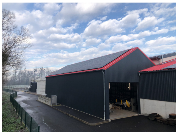
Photos du système photovoltaïque sur les toits de la station d'épuration
